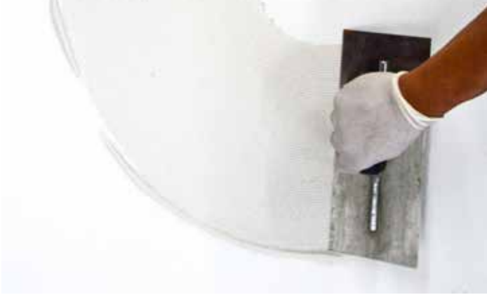
Pas 1 Pour démarrer la couche d'adhérence, utilisez le côté plat d'une truelle pour appliquer fermement le mortier à pose au substrat.
