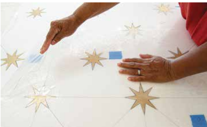
Pas 5 Après 24 heures de temps de cure, enlevez le ruban adhésif des mosaïques en commençant par un des coins. Faites un mouvement en angle descendant.
