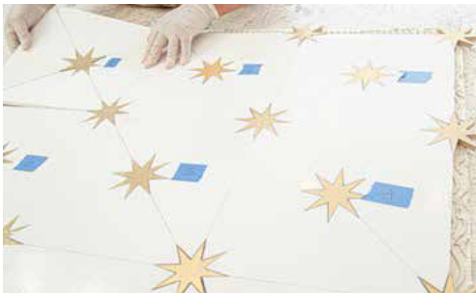
Pas 3 Appliquez les feuilles de mosaïque à la couche d'adhérence de mortier à pose, le ruban adhésif envers vous, avec une pression légère et soutenue. De façon périodique, vérifiez que le mortier à pose ne se sèche pas, même légèrement. Si ceci arrive, enlevez le mortier à pose et appliquez-le à nouveau.
