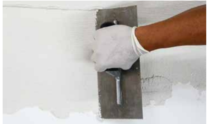
Pas 2 Pour établir la hauteur appropriée de la couche d'adhérence, utilisez une truelle de 3/16" x 1/4" [50 a 63mm] à entaille en v pour appliquer du mortier à pose supplémentaire et 'peigner' des sillons continus dans une direction.
