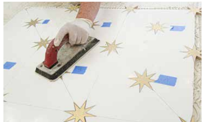
Pas 4 Pour obtenir la surface la plus plate possible, tapotez légèrement les feuilles en exerçant une légère pression avec un flotteur de coulis ou un bloc d'impact en bois et un marteau de finition. Afin d'unifier les transitions de feuille à feuille, tapotez d'une feuille à l'autre.
